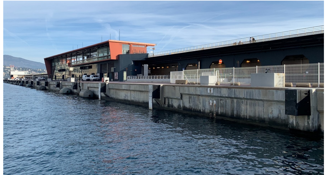
Vue des anciens aménagements View of the previous equipment
