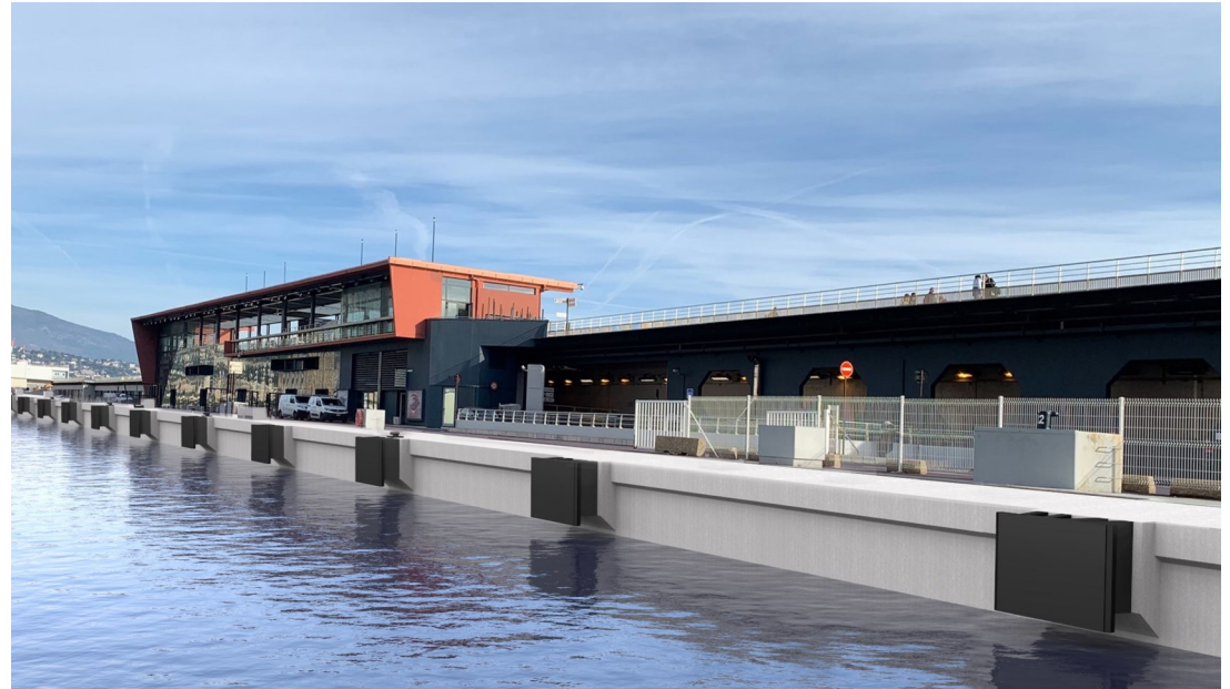
Vue des nouveaux aménagements View of the new equipment
